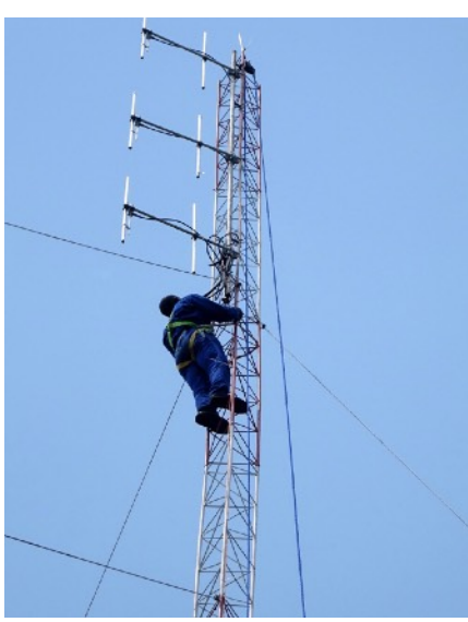
Elvis, notre technicien, installe une antenne en haut d'un pylône de 50 m - avril 2017 à Bangangté (Cameroun).
